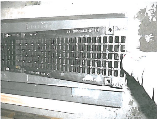
Schritt 2: Gussrost einlegen.
