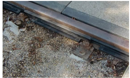
Foto 4 Die beiden Platten werden in Montageposition gebracht
