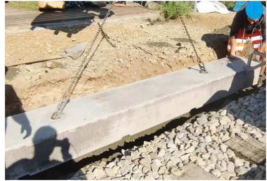
Foto 7 Einbau Fundamentbalken WUB
