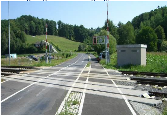
Foto 16 Fertig eingebauter Übergang, Österreich
