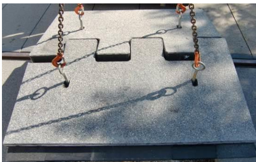
Foto 5 Die beiden Platten in eingebautem Zustand ohne Verschlussstopfen
