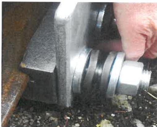
11. Vor dem Anziehen der Muttern auf den optimalen Sitz des Klemmplattenhalters achten. Halteplatten, mit oder ohne Gummipuffer, müssen konisch an der Plattenstirnseite anstehen und gleichzeitig das Gummiprofil gegen das Auswandern sichern.
