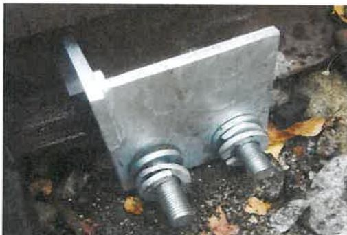
8. Anschließend pro Gewindestange je Seite 1 Stück doppelten Federring anbringen. (insgesamt 4 Stück Federringe)
