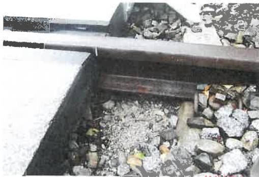
1. Gleisschotter unter dem Schienenfuß entfernen
