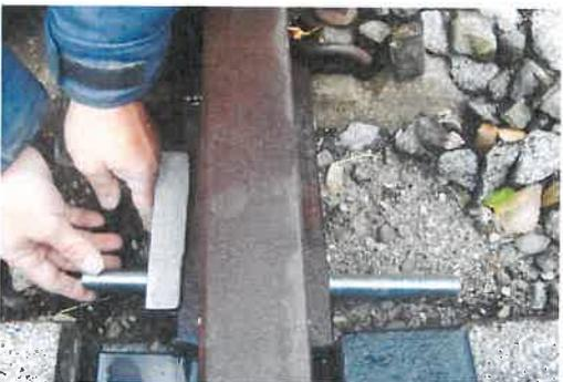
4. Die Gewindestangen unter dem Schienenfuß im 90° Winkel durchstecken.
