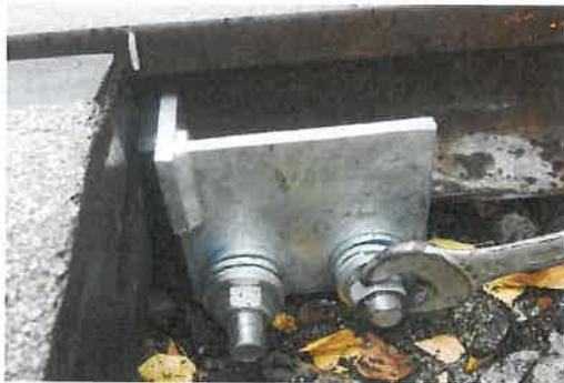
10. Zum Schluß wird auf jedes Ende der Gewindestangen je eine Mutter geschraubt. (insgesamt 4 Stück Muttern)
