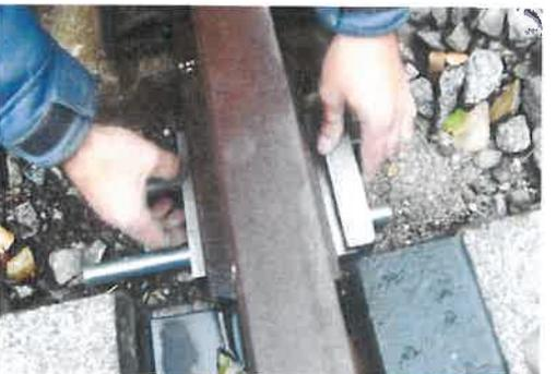
5. Auf beiden Seiten der Schiene die Klemmbackengußteile, mit dem Haken nach oben, auf die Gewindestangen auffädeln. Den Haken des Klemmbackengußteils in den Schienenfuß einhängen.
