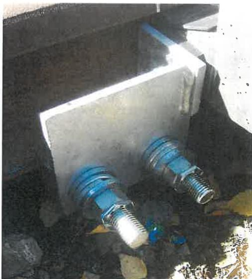
12. Abschließend die Palmuttern (Sicherungsmuttern) auf alle Gewindestangenenden anbringen und mit dem Gabelschlüssel festziehen (insgesamt 4 Stück Palmuttern).
